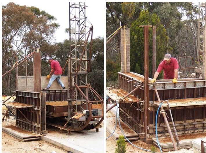
**Figura 2.** Colocación de sistema metálico para la construcción de muros (Ramed Earth Enterprises, 2020).
