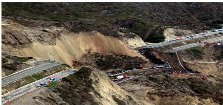
**Figura 4.** Deslizamiento de terreno en carretera Escénica Tijuana-Ensenada ocurrido en diciembre de 2013, atribuido a falta de estudios geológico-estructurales y geomecánicos (foto <http://www.4vientos.net/>).
